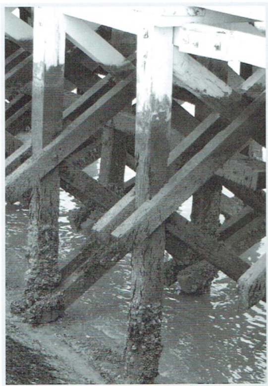
Detail van de constructie van de kruisgebinten van het Westerstaketsel
