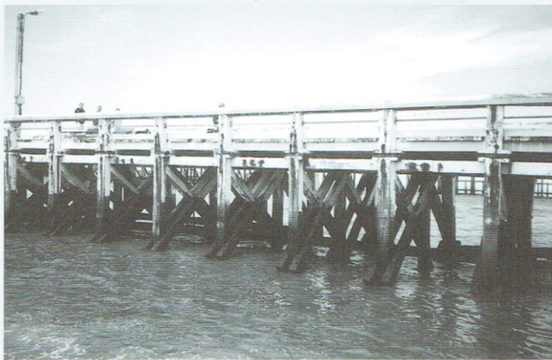
Mei 2005. Detail van de constructie van het Westerstaketsel.
