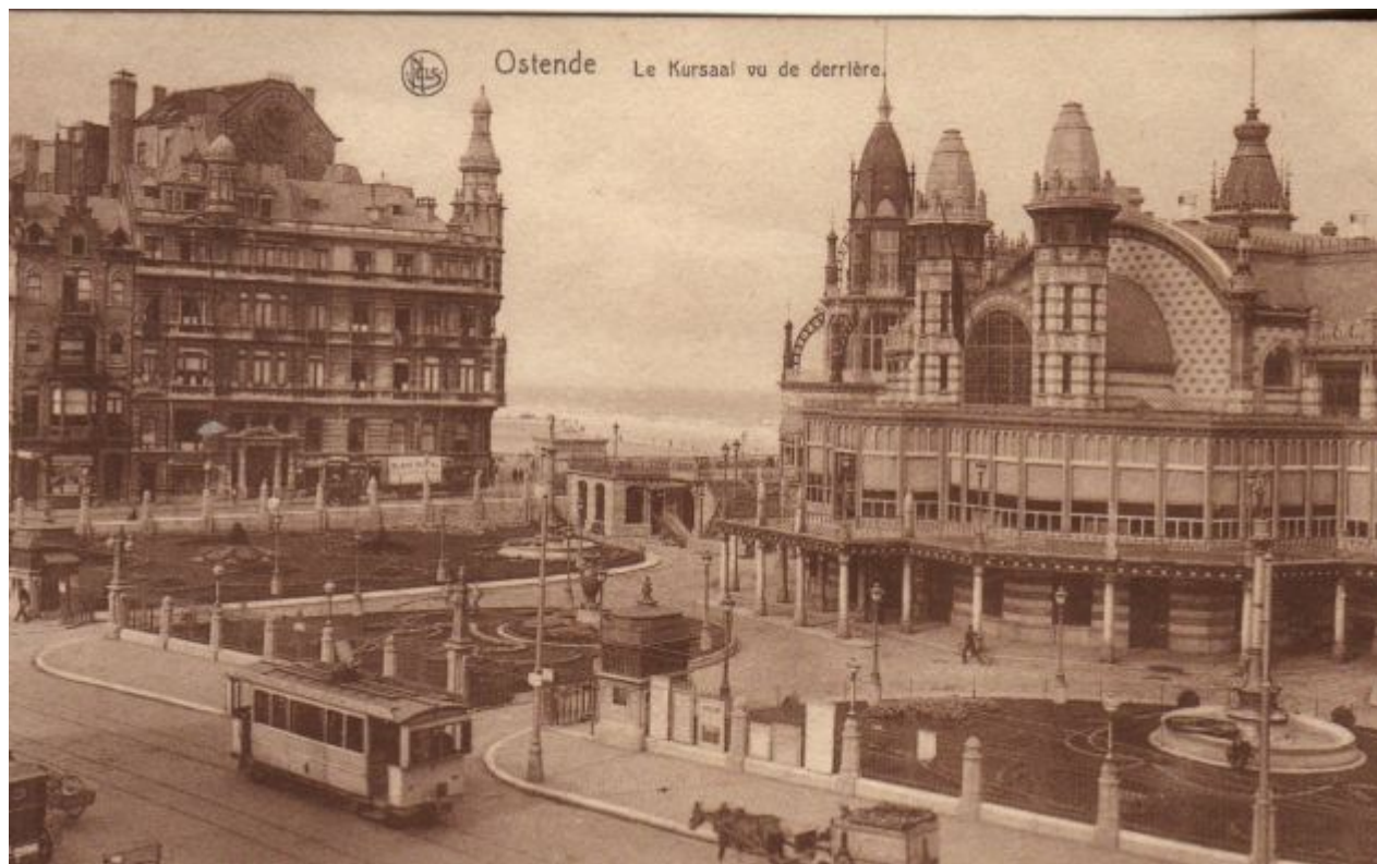
Le Kursaal vu du derrière
