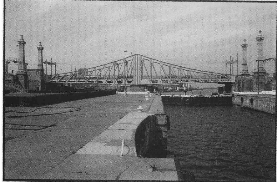
Sluizen en Graaf de Smet de Naeyerbrug
