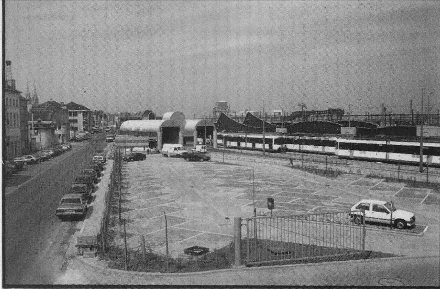
Tramwasinstallatie van De Lijn
