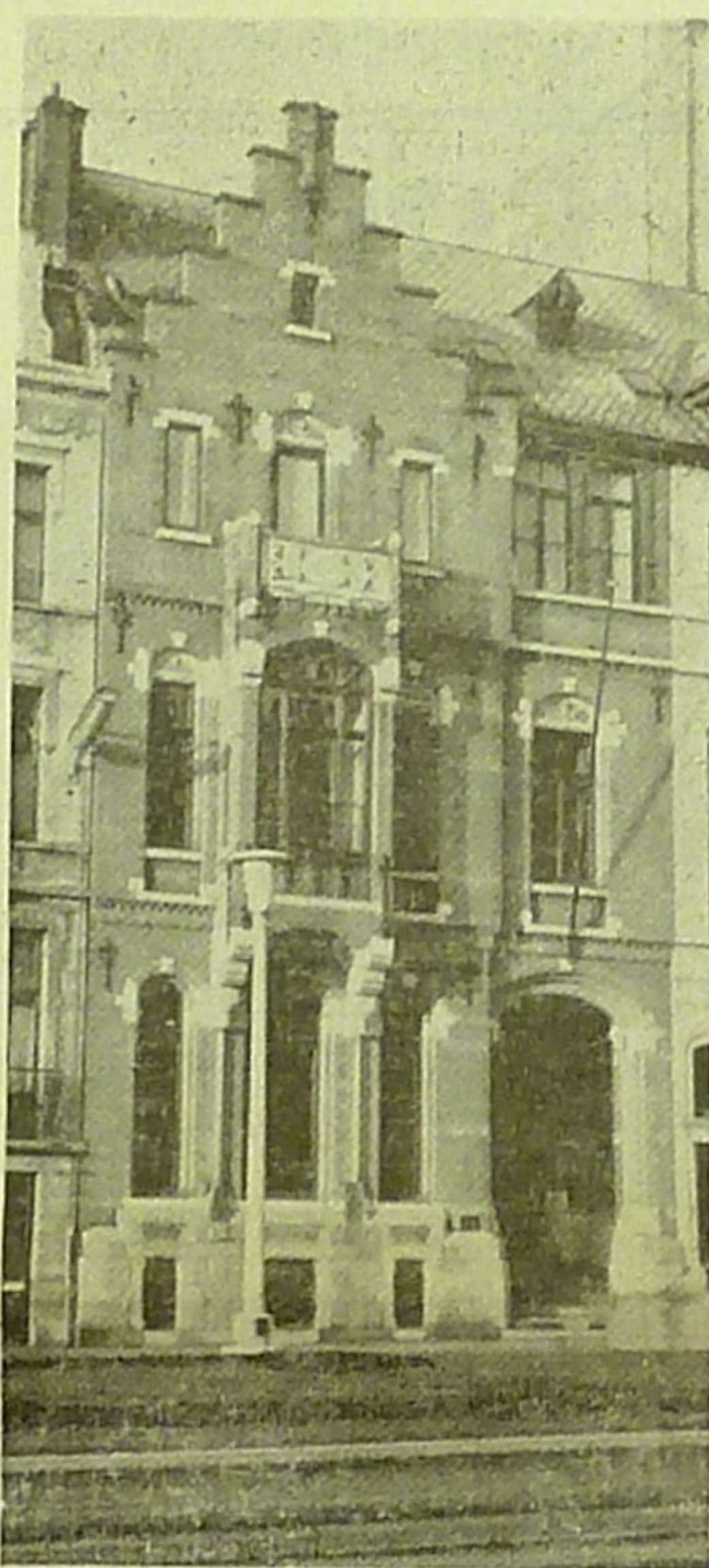
La façade de l'Ostend House telle qu'elle nous est encore familière.
