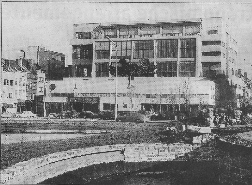
Het afgewerkte PTT-gebouw met de beeldengroep 'De Eenheid in de Wereld door het Postverkeer' van Jozef Cantré.
