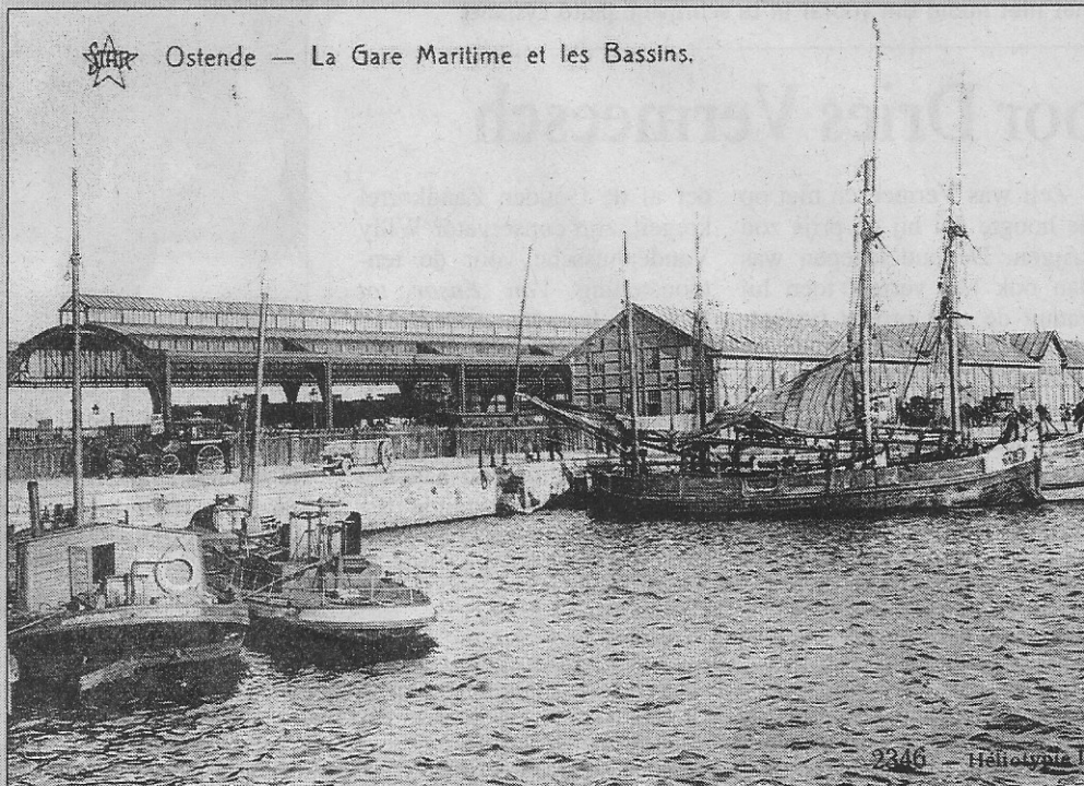
Het eerste zeestation dat meer op een hangar dan op een station leek.
