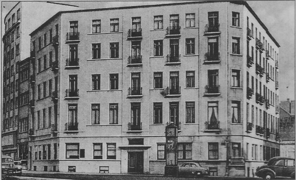
Het residentieel flatgebouw Le Commodore op de Albert I-promenade.
