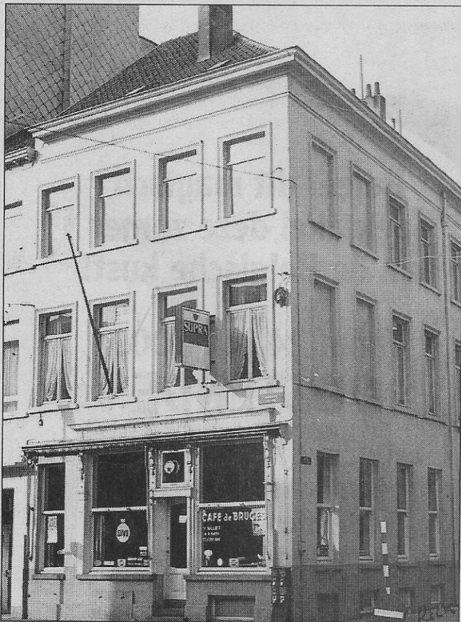
Café de Bruges op de hoek met de Ieperstraat
