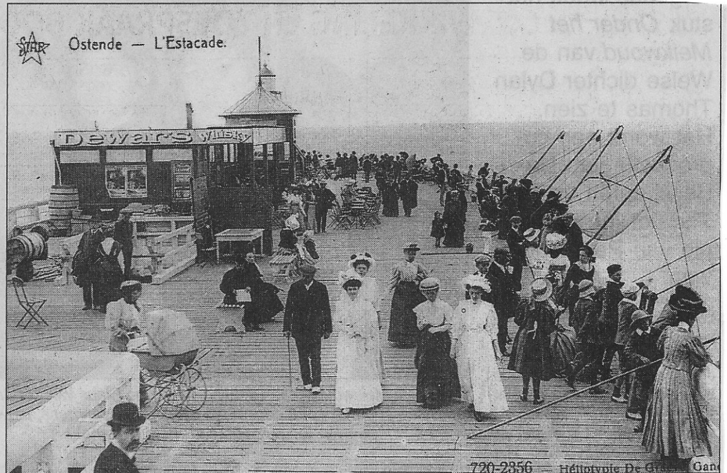
Een beeld uit 1905: het staketsel als uitverkoren wandelplek.
