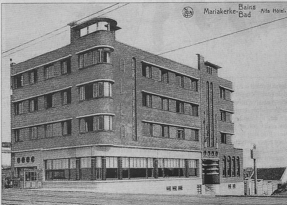
Het Alfa Hotel, het meest typische gebouw van de Bernard Christiaensstijl.
