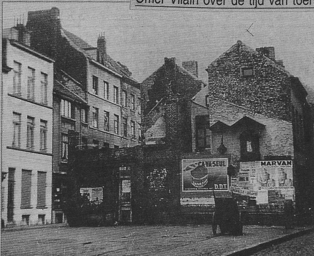
De verdwenen vismarkt en de kleine huizenblok tussen de Bonenstraat en de Kadzandstraat die in de jaren zestig onder de sloophamer is verdwenen.
