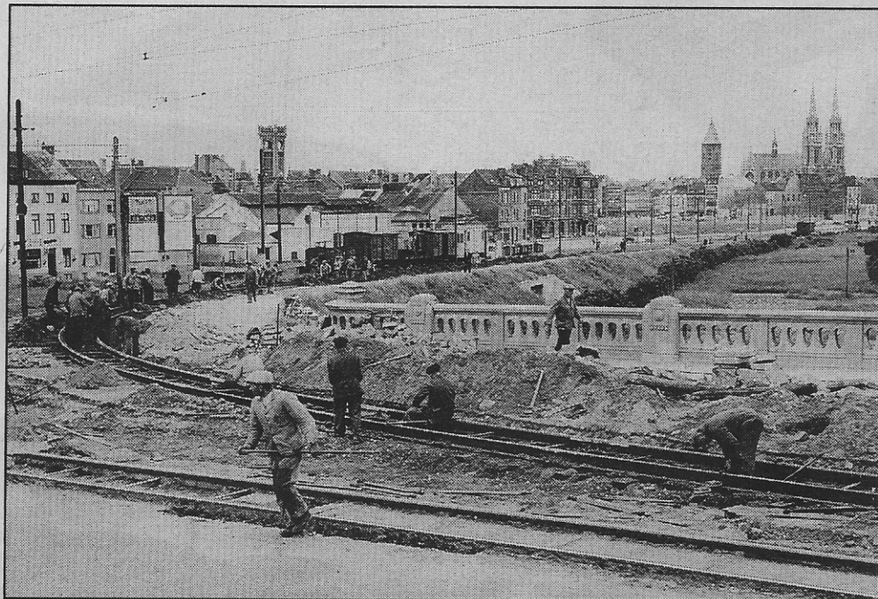
De oprit voor de trams wordt gemaakt aan de Smet de Naeyerburg. Links het oude slachthuis en verder de plaats waar de hotelschool zou gebouwd worden. Ook de toren van het oud-station ziet men nog.
