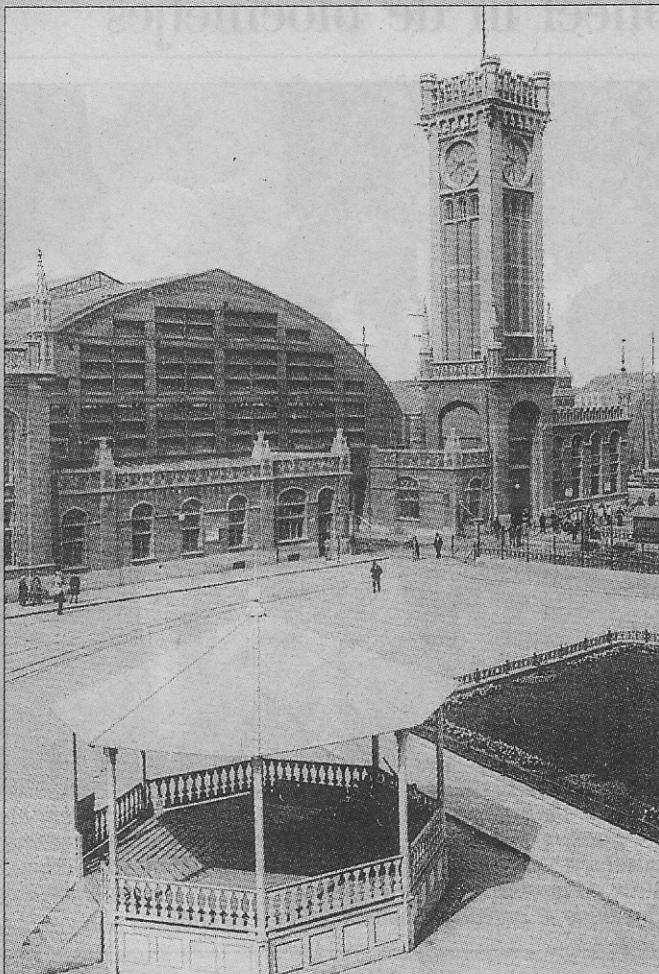
De mooie toren met uurwerk van het oud stationsgebouw (voor 1956).
