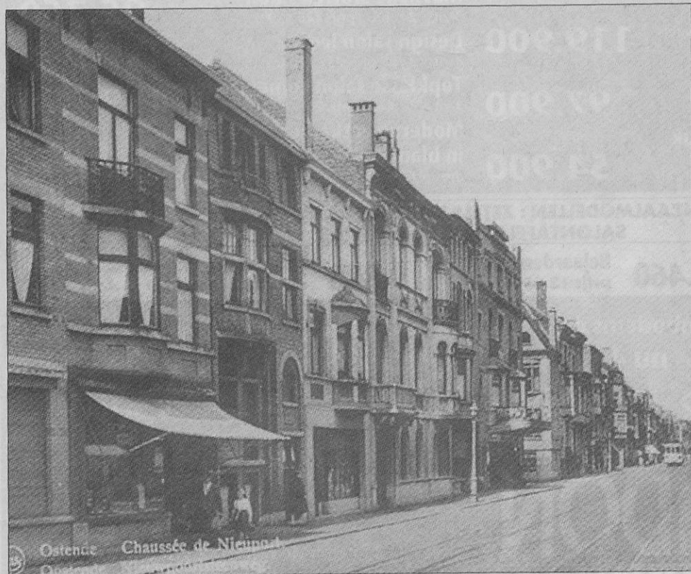
De Nieuwpoortsesteenweg gezien vanaf de H. Hartlaan (circa 1932).
