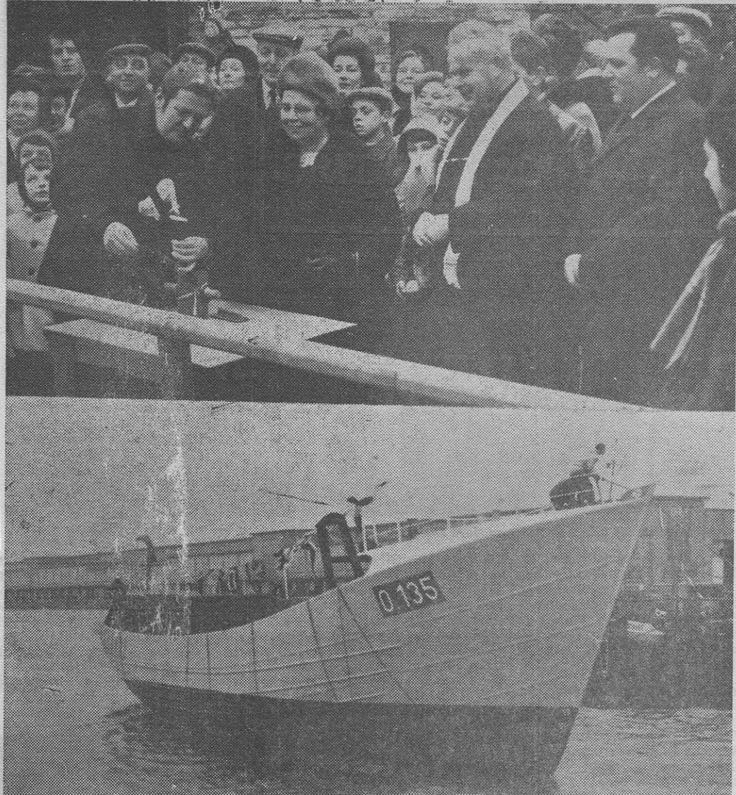
Zaterdag werd op de scheepswerf Seghers te Oostende de 0.135, gebouwd voor rekening van de hh. Bostoën en Verleene, te water gelaten. De wijdingsplechtigheid werd voltrokken door visserijaalmoezenier Cornellie. Peter en meter waren de h. Maurice Steenland en mevr. Irma Bostoën - Strubbe. (Foto Gilbert B).
