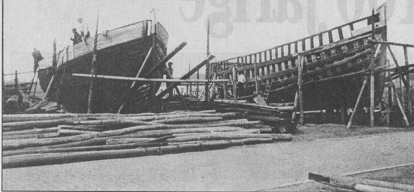
Een paar houten vissersschepen in konstruktie. Let op de partij boomstammen op de voorgrond. (1900)
