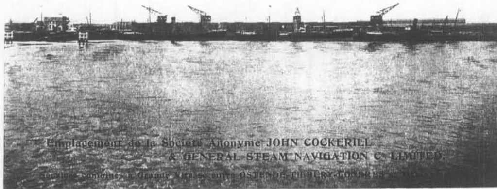
Zicht op de diepwaterkaai (Cockerillkaai) ca. 1912. We bemerken de drie schepen van de Cockerillvoet : Saphir, Topaze en Rubis en rechts één schip van de General Steam. De kaai is uitgerust met een grote hangaar en vier elektrische kranen
