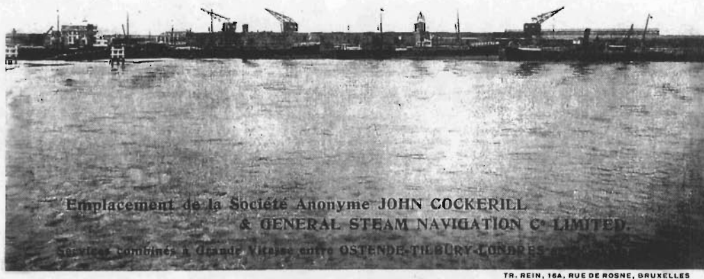
De diepwaterkaai ca. 1912 met de toenmaals vier nieuwe elektrische kranen en de grote hangaar, aanbesteed in 1908 en pas afgewerkt in 1911
