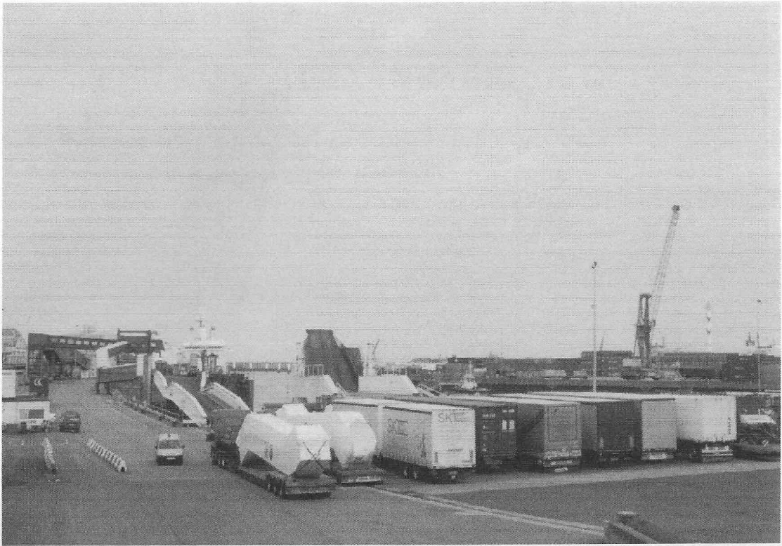
Fig. nr. 246. Haven Oostende, Pakketbotenkaai, 2006. Zicht op carferrybrug 4. Centraal op de foto de twe niveau's brug, links het zijlaadplatform. Links in de achtergrond de passagierskoker en hydraulische gangway. Bemerkt de uitbreiding van de koker naar het zijlaadplatform. Rechts, op de oosteroever een mobiele hijskraan voor het verhandelen van containers, (tot 2008).
