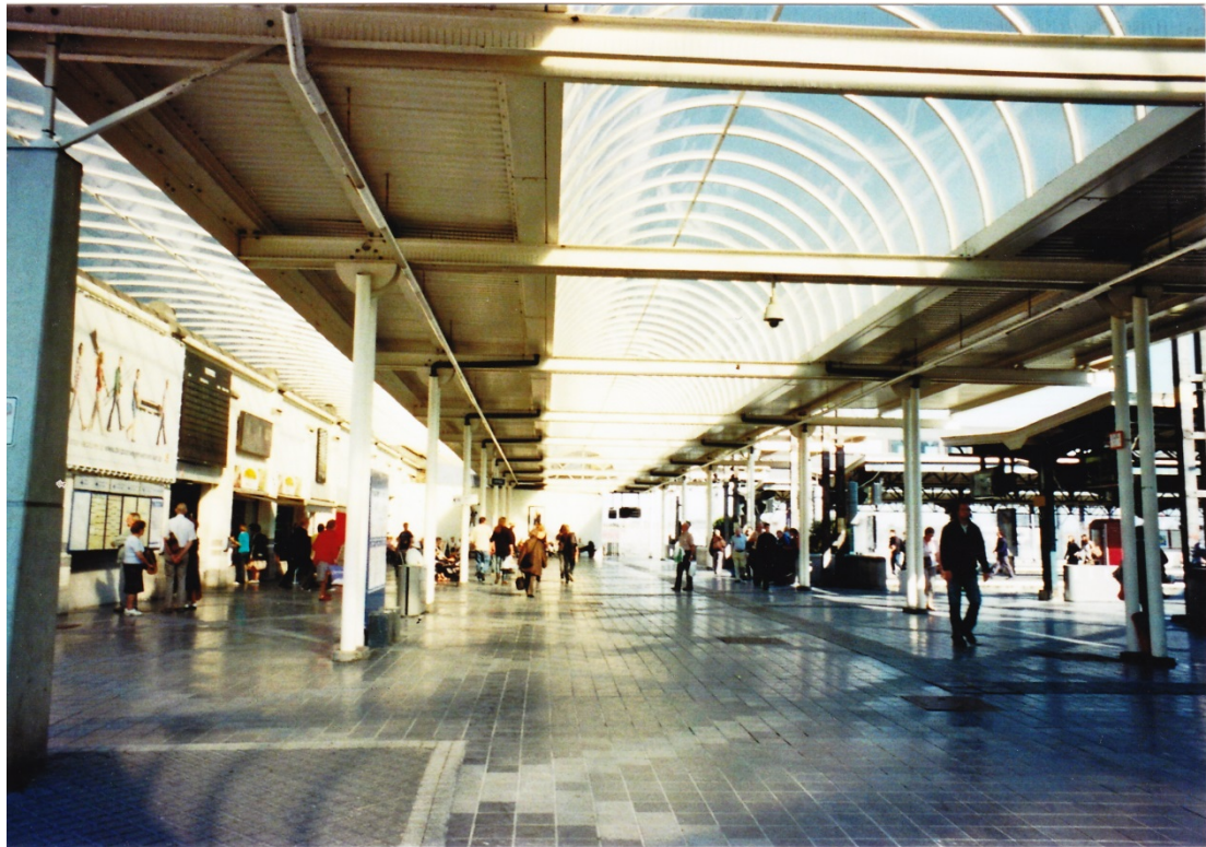
Fig. nr. 256: Haven Oostende, 2012, Zicht op de in 2012 gesloopte 'kop' van de perrons in het zeestation 'Oostende-kaai.
