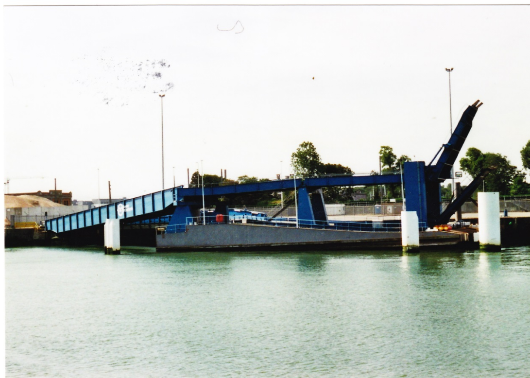
Fig. nr. 253: Haven Oostende, 2008, De nieuwe tweedeks ro-robrug aan de Diepwaterkaai t.h.v. de Zeevaatschool (nu: directiegebouw van de haven en gelegen binnen de zg. 'Schengenzone').
