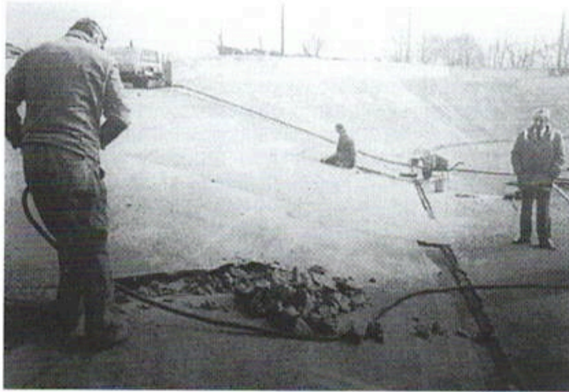
Herstellingen aan betonbaan van vierde wielerpiste §1946-1990)
