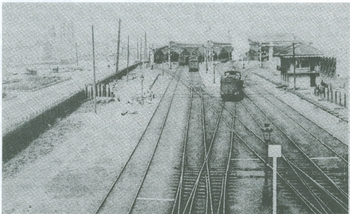
Fig. nr. 173 Haven Oostende. Zeestation Oostende-Kaai in 1913. Bemerck de 6 stationssporen en de spooroverkapping
