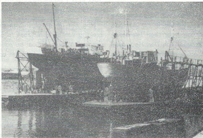
Slipway van 500 en 1.000 Ton.
