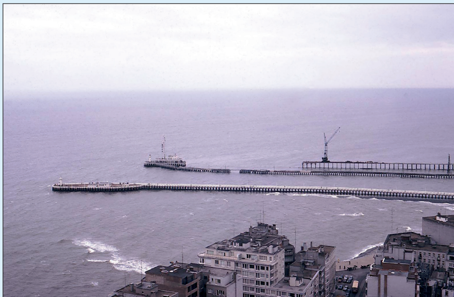
Staketsel ( 't Hooft' ) Oostende, 1970
