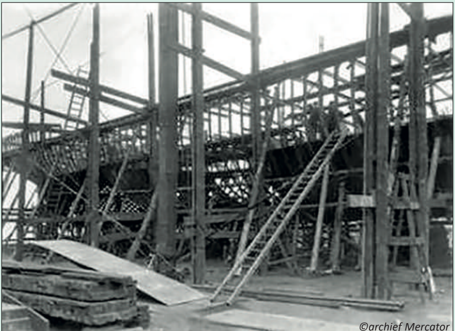
Scheepswerf Ramage & Ferguson, 1931. De Mercator in opbouw, zicht op de houten spanten.
