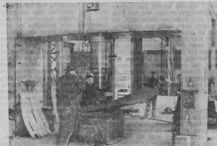
Hier wordt aan de platen waaruit straks een scheersromp wordt geboren een eerste vorm meegegeven. (foto Gilbert B.)
