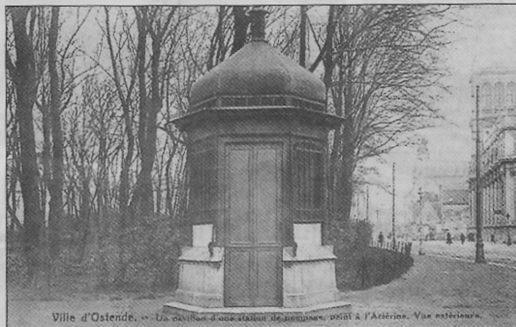
Ville d'Ostende. „Un pavillon d'une station de pompage, peint à l'Acierine. Vue extérieure.” Het toegangspaviljoen naar de rioolpompen in het Leopoldpark ter hoogte van de Jozef II-straat (Circa 1910).
