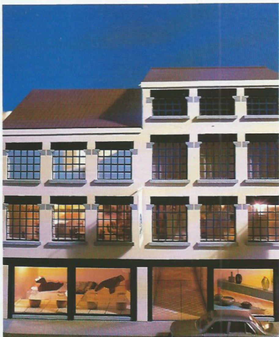
GEVEL MERCATORPAND IN DE DEKENIJSTRAAT
