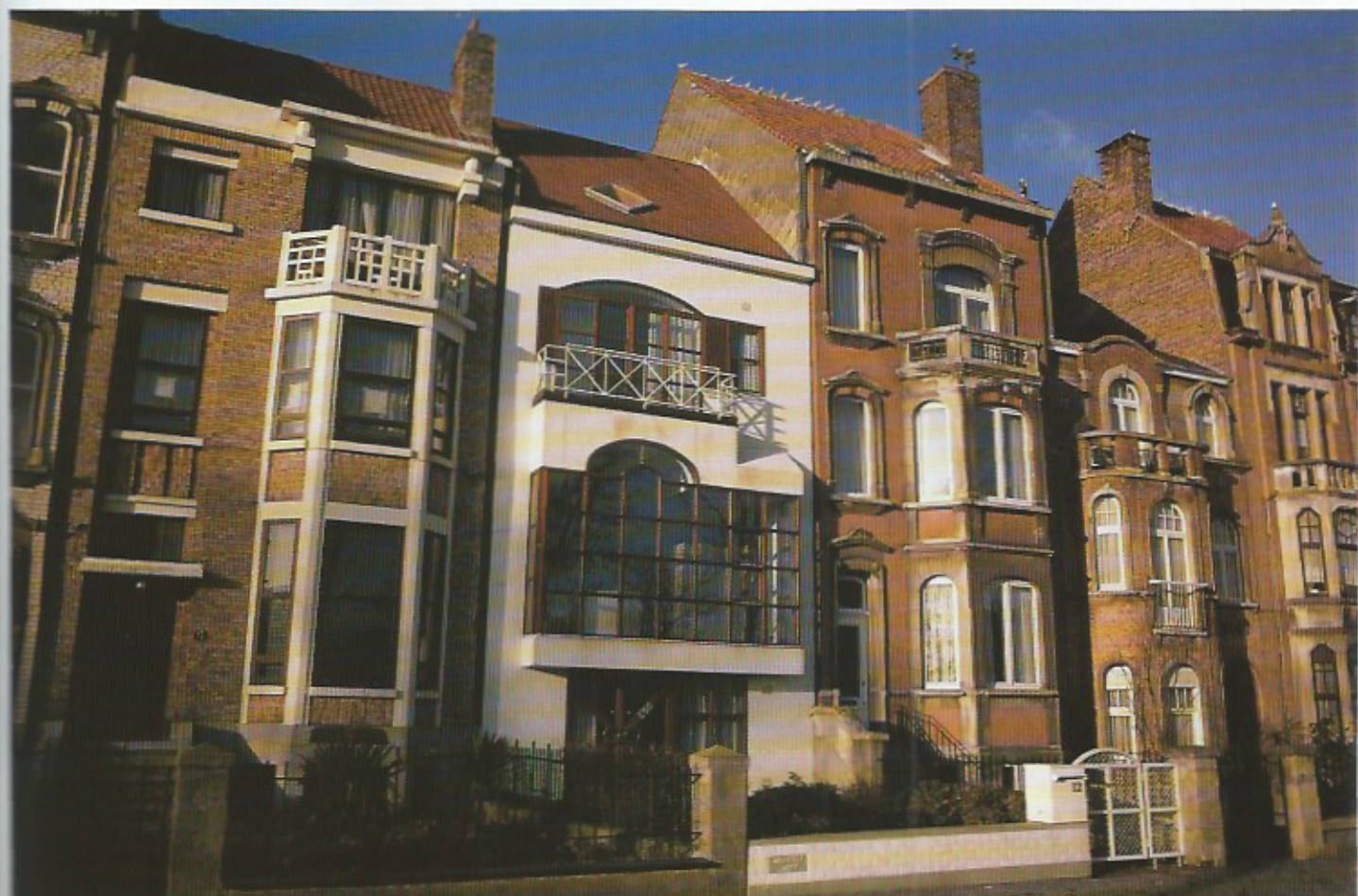
De postmodernistische gevel van de woning van architect H. Labyt past wonderwel bij de oude gevels van de belle époquevilla's aan de residentiële Prinsenslaan.
