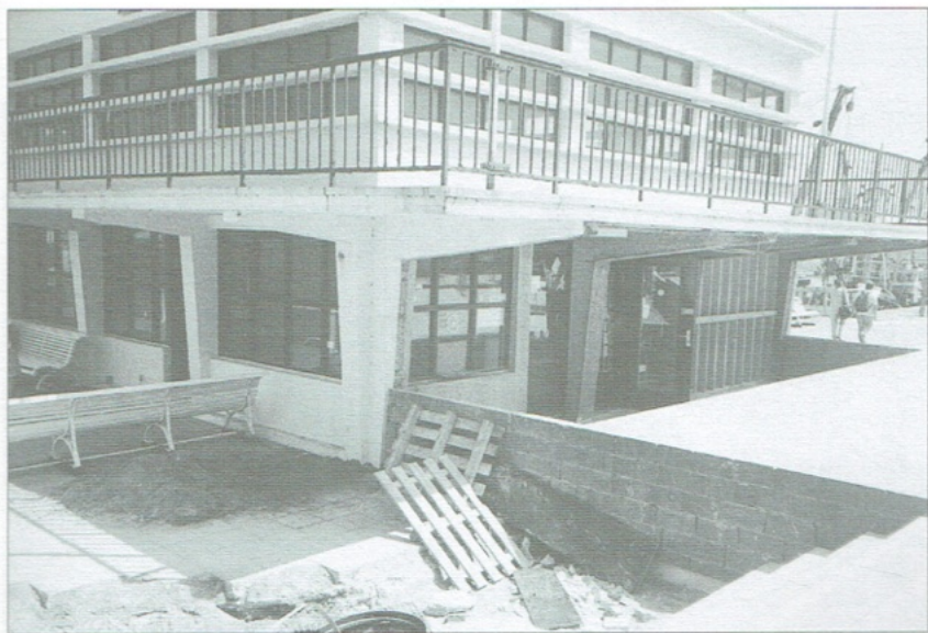
Bemerk links de noodingang tijdens de werken op de Visserskaai en de lege bak onder de luifel waar vroeger de hoofdingang was.
