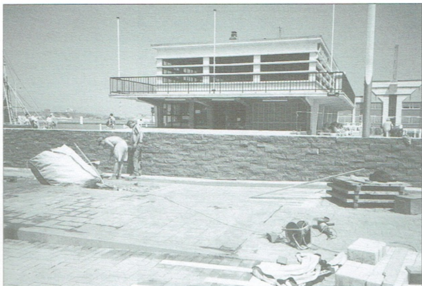
Straatwerken op de Visserskaai vóór het Aquarium (juni 1999)
