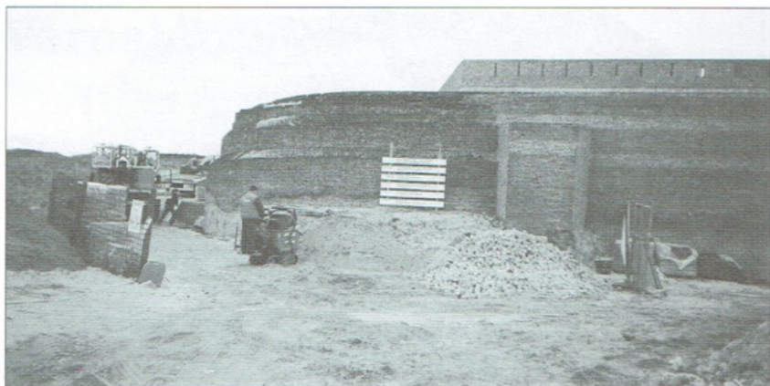
Nog volle werkzaamheid voor de toegang tot het Fort Napoleon. - 15/03/2000
