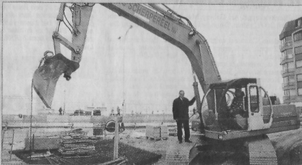
He has the whole world in his hand ! Ofte Jean Vandecasteele op een graafmachine die er moet voor instaan dat tegen de zomer aan de Visserskaai een amfitheater — met 550 zitjes — verrijst.
