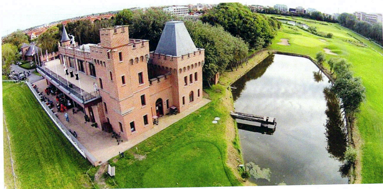
Het huidige gebouw dat als clublokaal van de golf fungeert
