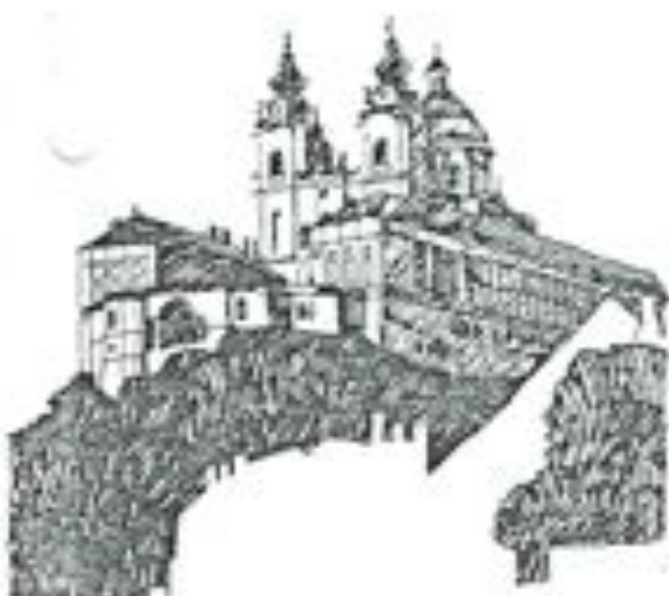
het klooster Melk (Oostenrijk), op een rots gelegen, door Brandstuber (behouden in 1702)
